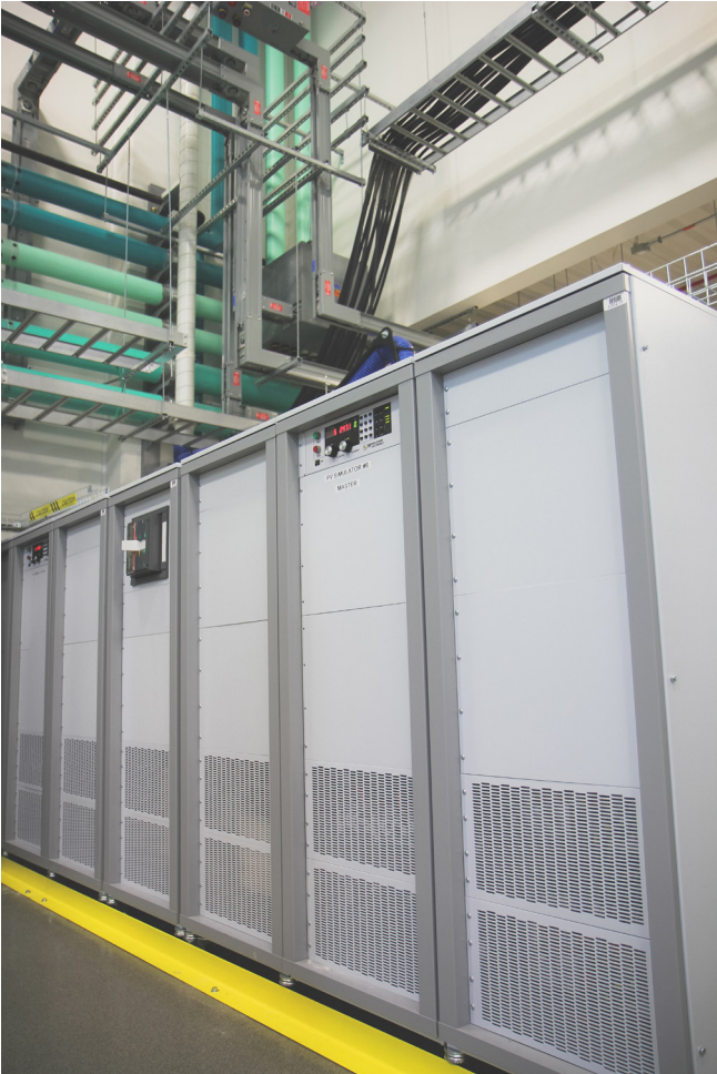
1.5 MW太阳能电池阵列模拟器在科罗拉多州戈尔登的国家可再生能源实验室 (NREL) 使用麦格纳电子设备公司的MT系列电源
